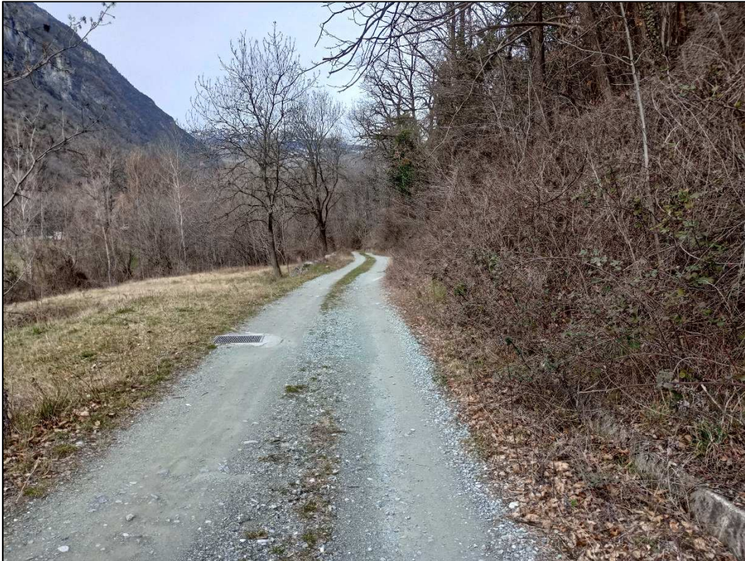
Fig. 10 – Un altro tratto in cui il canale è intubato a monte della strada al piede del versante
