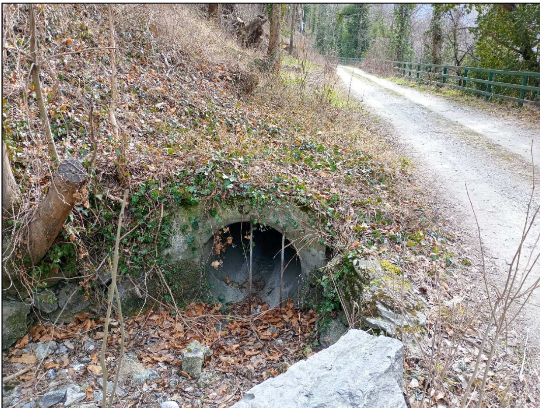
Fig. 9 – L'imbocco di uno dei tratti in cui il canale scorre intubato
